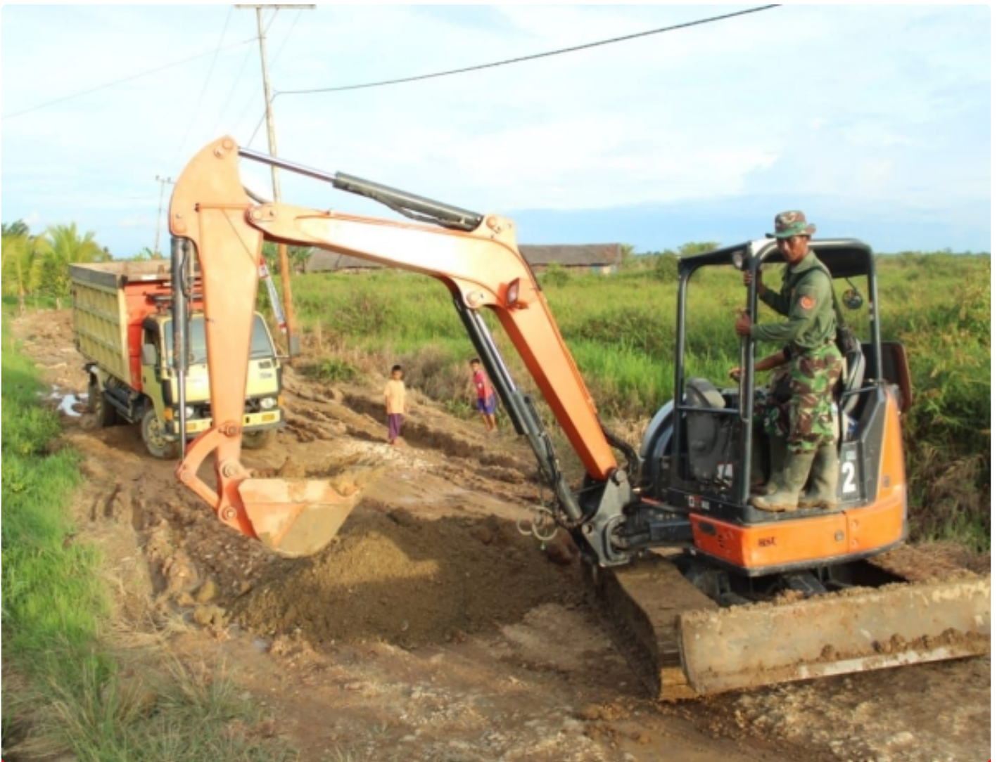
Satgas TMMD ke-115 Kodim 1001/Hsu-Blg Kerahkan Excavator
